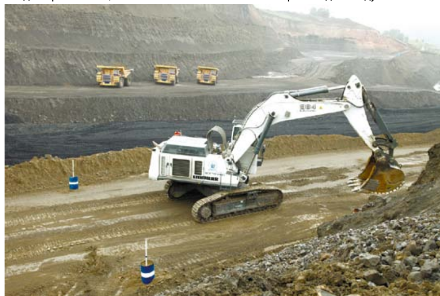
Накануне Дня шахтера в ХК «СДС-Уголь» состоялось открытие нового предприятия — разреза «Восточный»
