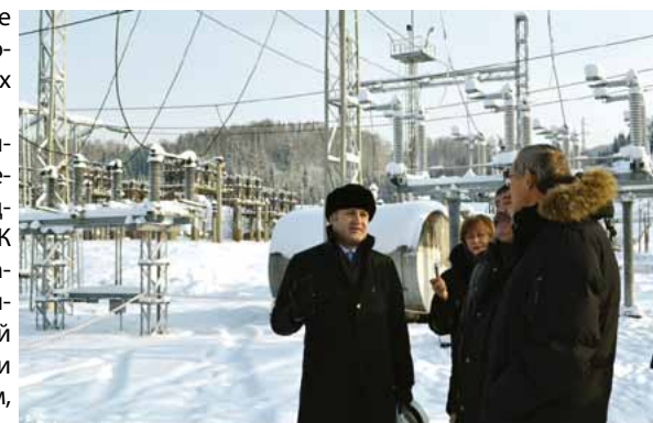
Директор филиала Евгений Тюменцев докладывает заместителю губернатора Андрею Малахову о проведённой реконструкции подстанции «Кондомская»
