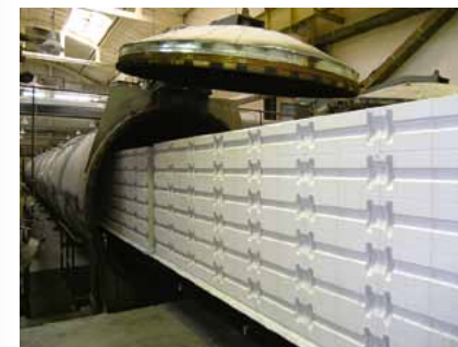
Процесс выгрузки готового газобетона СИБИТ из автоклава
