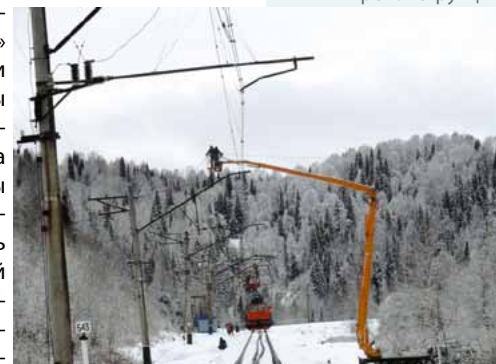
Монтаж провода на переходе через железную дорогу
