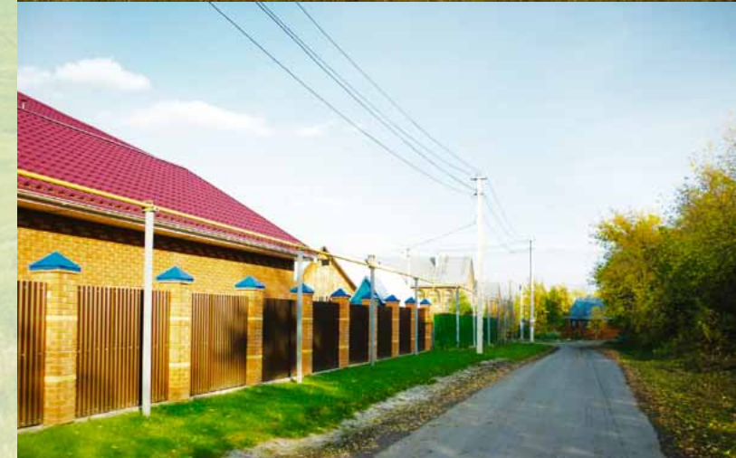
Реконструкция ВЛ -0,4 кВ в поселке Металлплощадка
