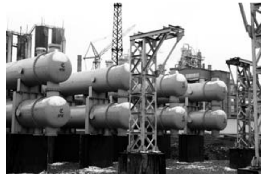
Площадка коксохимического производства – монтаж оборудования
