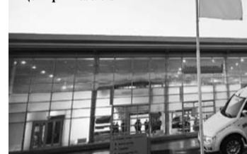
3 октября в Кемерово ООО «Трансхимресурс» открыло самый большой за Уралом дилерский центр Mitsubishi
