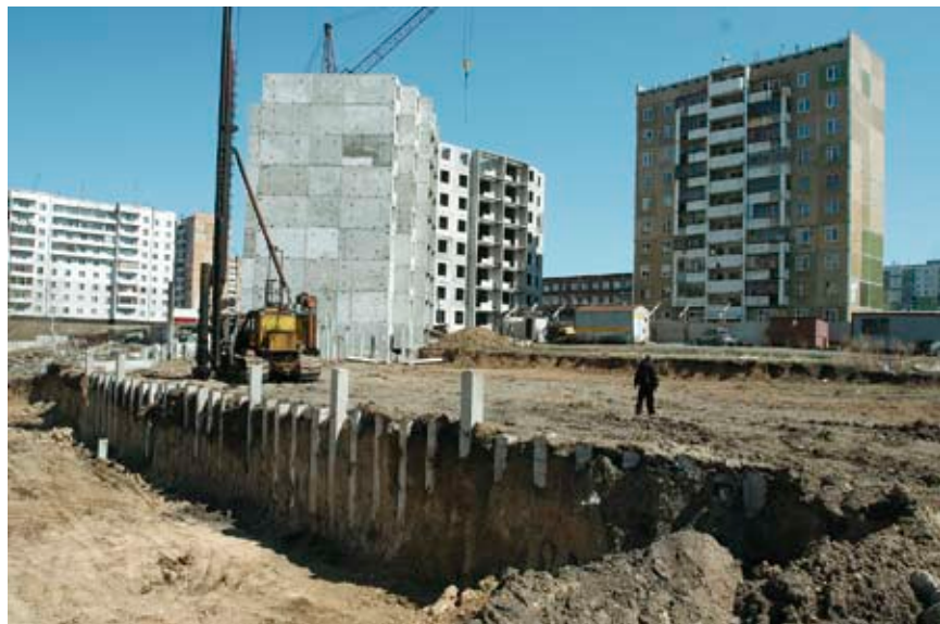
Сейчас в Кемерово на начальной стадии строительства находится порядка 15 площадок
