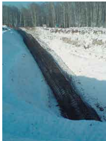
Строительство открытой галереи флангового путевого ствола на ш. «САЛЕК»
