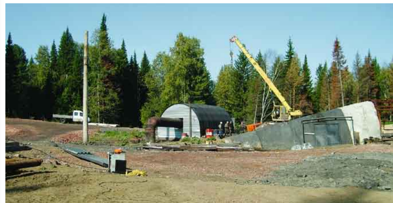
Промплощадка строительства флангового бремсберга № 21 ш. Березовская
