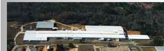
Фабрика по изготовлению кабеля в г. Эль Дорадо, Арканзас
