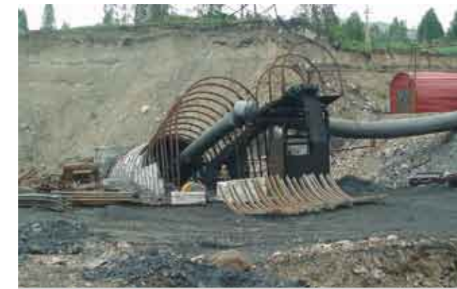
Строительство галереи путевого наклонного ствола на ш. «Сибиргинская»
