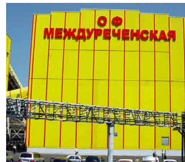
Новая фабрика «Междуреченская» была открыта в июне 2005 года через 22 месяца с начала строительства
