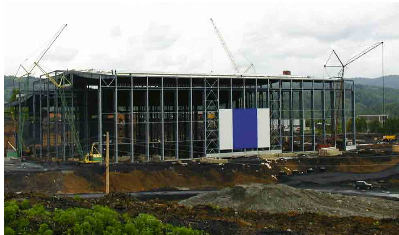
Самым крупным проектом по строительству новых обогатительных мощностей стало строительство углеобогажительной фабрики годовой мощности 9 млн тонн в составе компании «Распадская»
