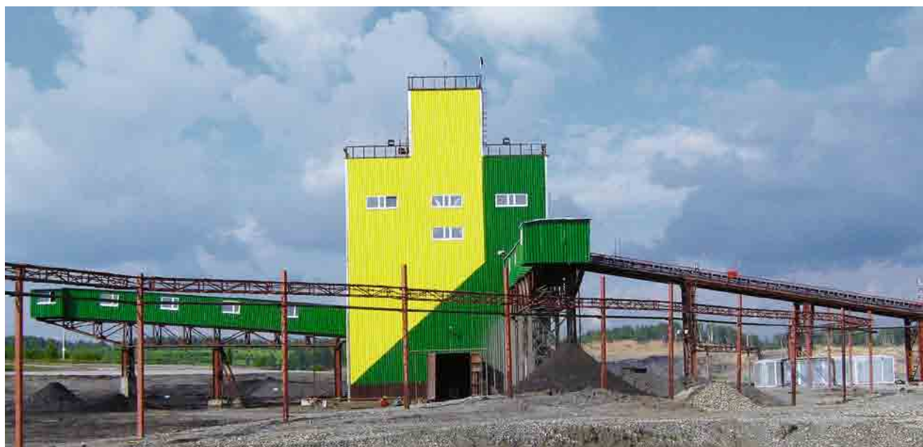
Обогатительная установка с крутонаклонным сепаратором КНС «Тажная» на разрезе «Талдинский»
