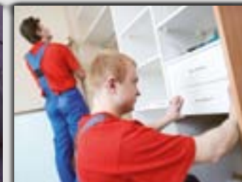
Монтаж любой сложности
