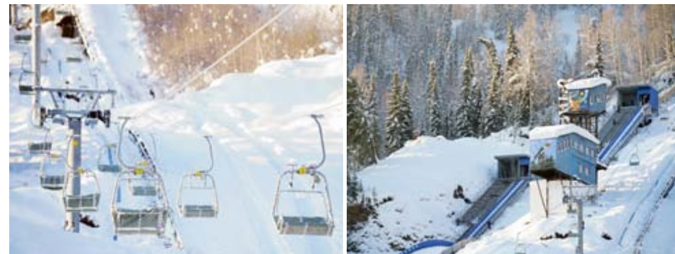
В Междуреченске на горнолыжном комплексе «Югус» реконструированы трамплины К-40м и К-62м, построен новый подъёмник, отремонтированы здания судейско-тренерского блока Центра зимних видов спорта
